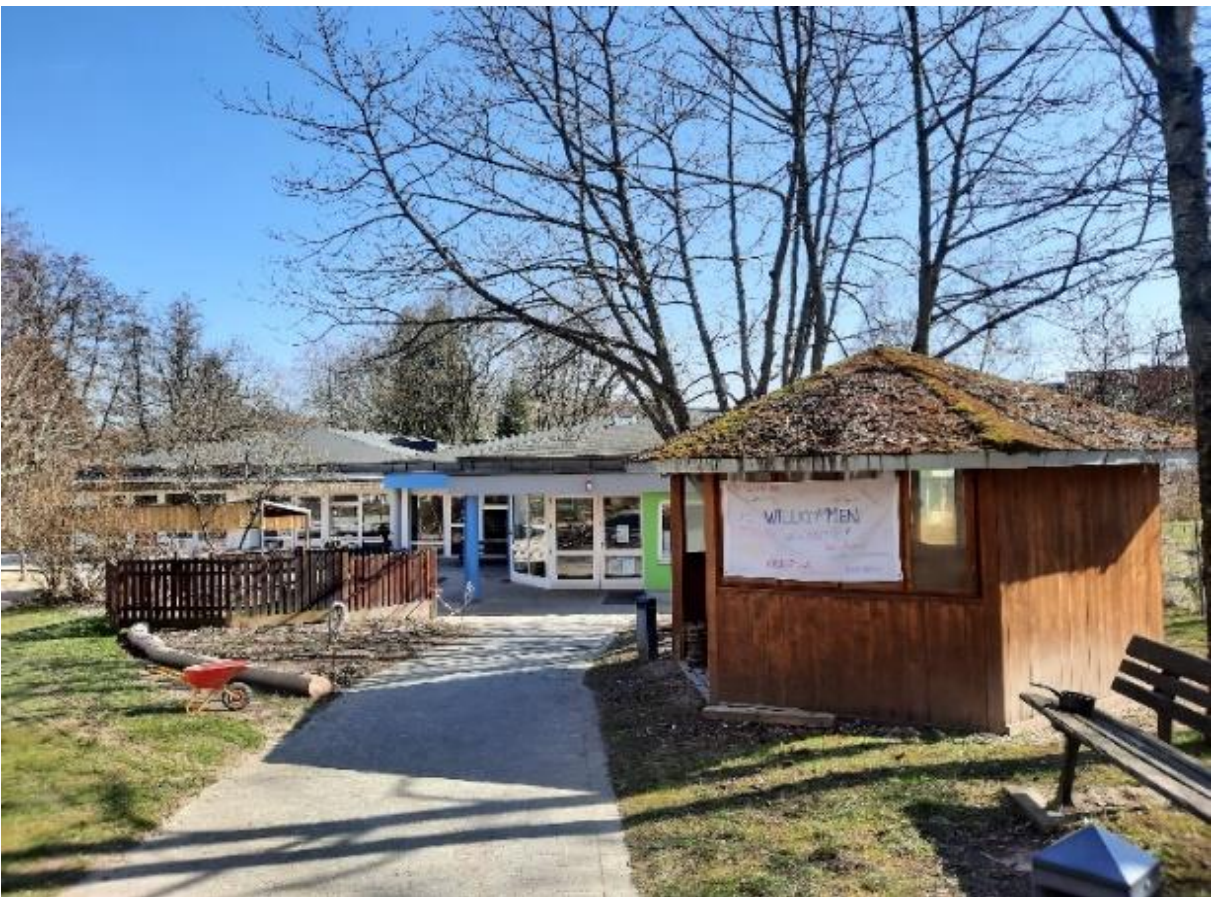
Abbildung 114 Kita Pusteblume (Eingangsbereich)
