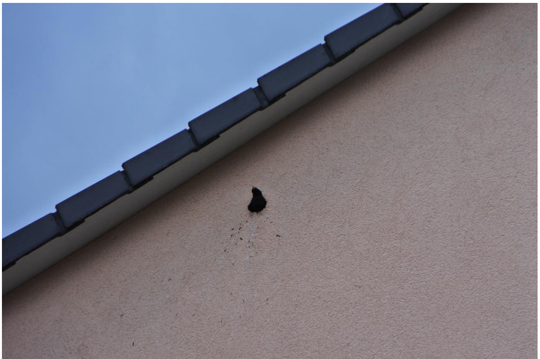
Abbildung 7: Star Sturnus vulgaris nistet in der Fassade am Nachbarhaus (Foto: BG Natur).
